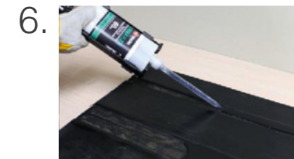
6. Permaflex Reparaturmaterial auftragen
