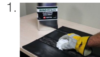
1. Gründliche Reinigung der Bearbeitungsfläche
