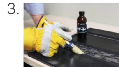
3. Vorbereitung mit speziellem PF-84 Primer
